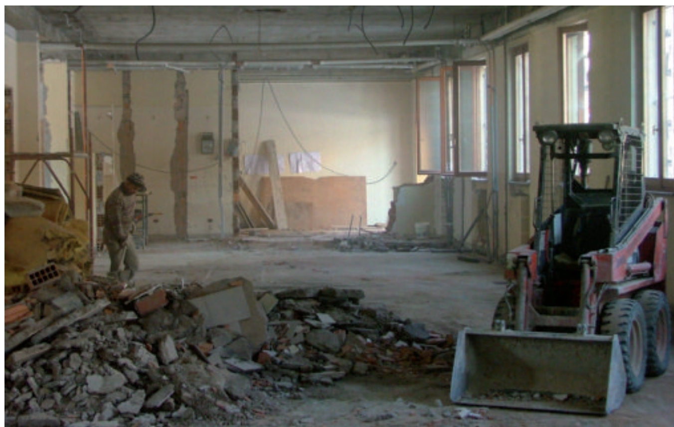
Lavori in corso al Convento dei Cappuccini di Piazzale Velasquez a Milano, dove sarà trasferito l'ambulatorio di Opera San Francesco
